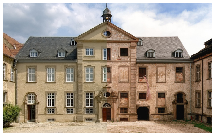
Vorher / nachher: Die Bildmontage zeigt den Zustand der barocken Schaufassade vor (r.) und nach der Restaurierung (l.).
